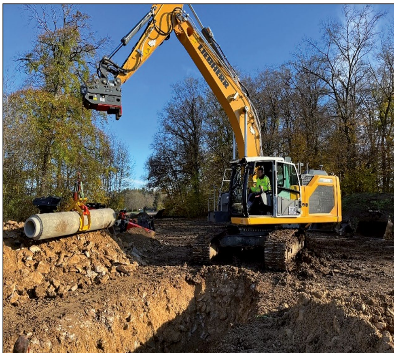
Bild 11: Bagger mit GNSS-Steuerung und hinterlegter Leitungsplanung auf Basis eines IFC-Modells [6], [15]
